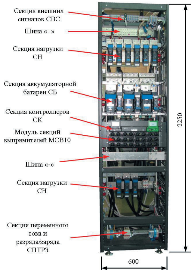
Рисунок 3.4 - Расположение основных частей ЩТР-5
